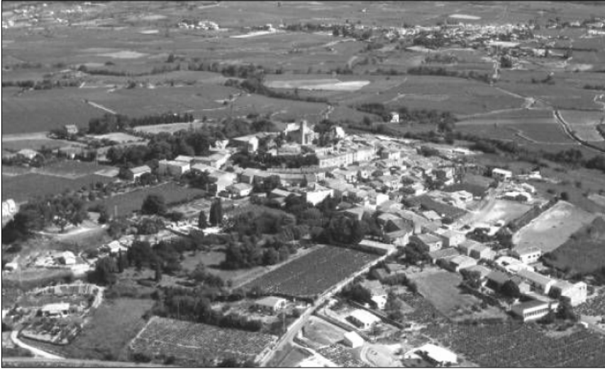
SAINT-PONS-DE-MAUCHIENS (HÉRAULT): DÉGRADATION DU PAYSAGE
