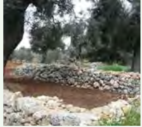
Muretti a secco in oliveti del Brindisino
