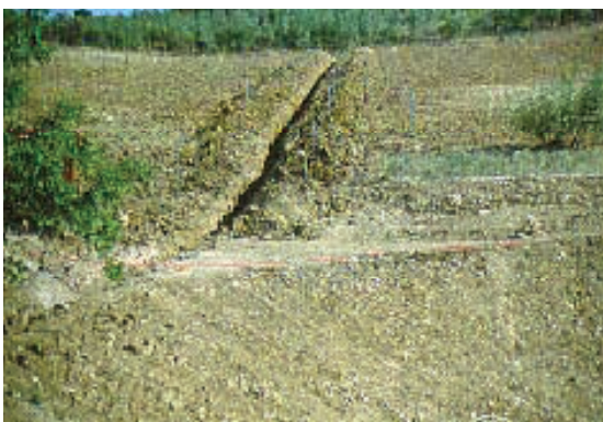
Figura 21. Creazione di drenaggi nelle linee di compluvio.
