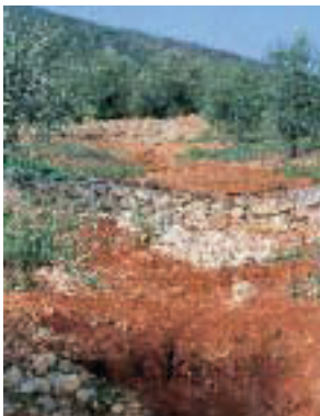
Figura 32. Gabbioni con pietre, costruiti per ridurre la velocità dell'acqua.
