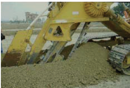
Figura 23. Scavo e sistemazione in profondità del tubo di drenaggio.
