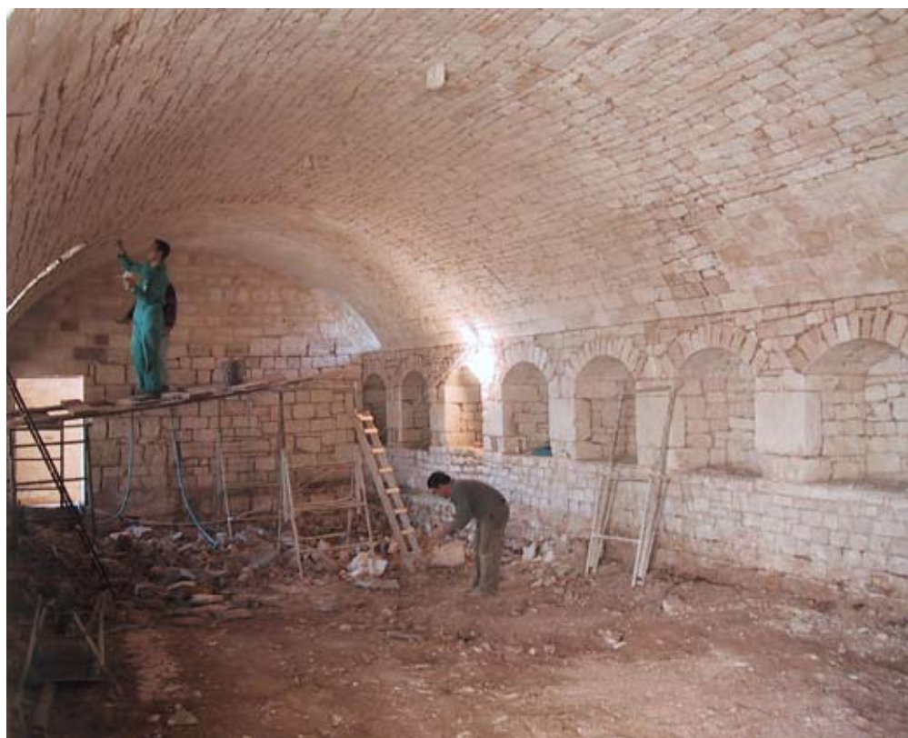
FIG.1 RISTRUTTURAZIONE ED ADEGUAMENTO EX STALLA AD AULE DELLA FORMAZIONE.
